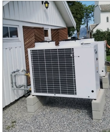
Eks. på VPs utedeler før bygningsmessig skjerming
