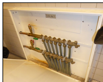
Gulvvarme rørdeling innvendig
