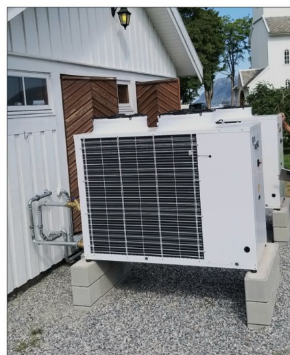
Eks. på VPs utedeler før bygningsskjerming
