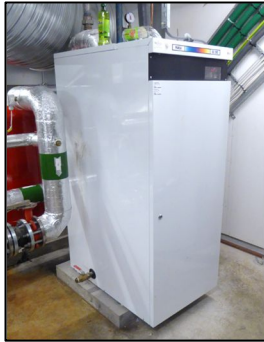
El-kjel – kapasitet 175 kW
