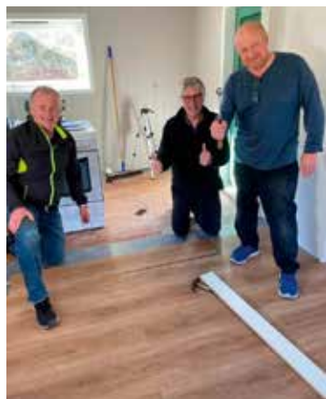
Tre stolte Y'men etter at det nye golvet har kome på plass. Frå venstre Johan Jensen, Svein Olav Klovning og Johan Dahl.
